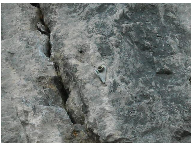
Spit-fix. Al di sopra e di lato sono visibili i fori di precedenti chiodature
