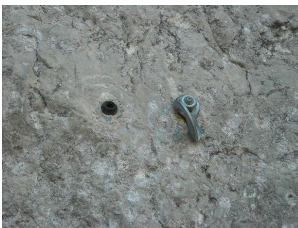
Spit-fix. Al di sopra e di lato sono visibili i fori di precedenti chiodature
